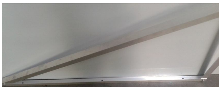
Widok otworów montażowych do połączenia trójkąta z kotwami dachowymi
